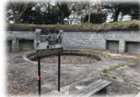
砲台山 北部砲台跡
